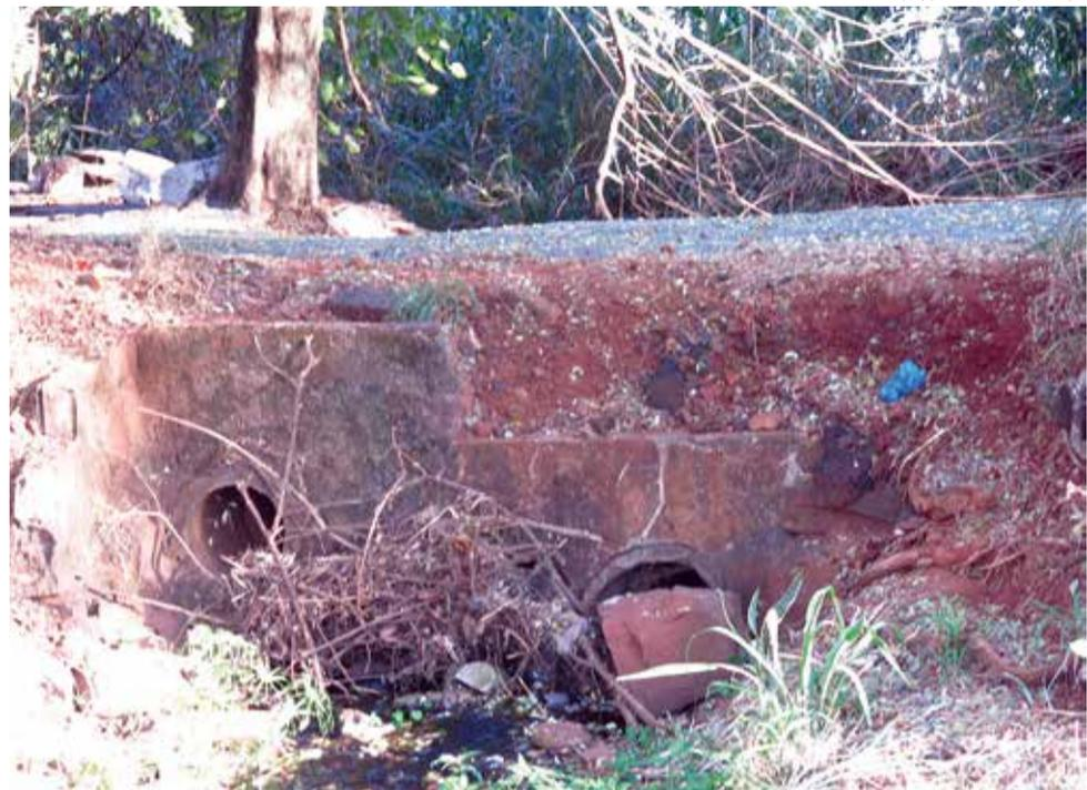
Tubulões não dão vazão e a água da chuva passa por cima da ponte, antes da gruta
