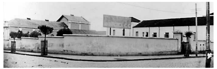
Acima, o terreno do Antarctica Cestobol Club . O prédio, no início da construção, e abaixo, já com a estrutura montada
