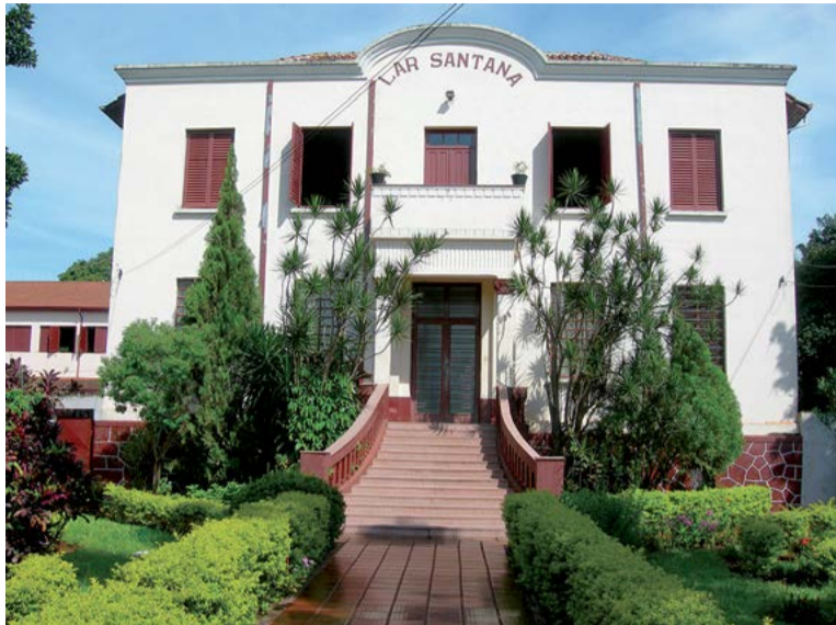
O prédio do Lar Santana foi tombado e aguarda permuta
