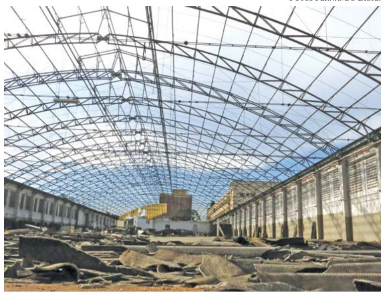
O depósito foi destelhado em dezembro de 2013, mas a demolição parou aguardando laudo da Cetesb
