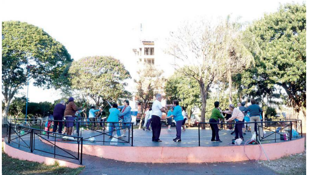
Os ferros de proteção do coreto da Praça José Mortari, onde o pessoal do PIC faz ginásticas nas manhãs de segunda, quarta e sexta, estão sendo roubados. Precisamos de mais fiscalização
