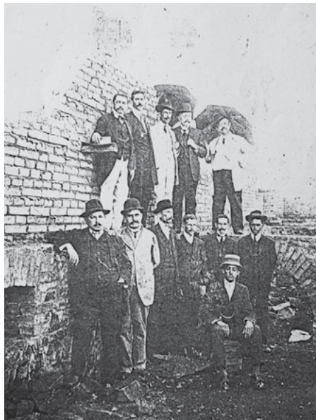
Fachada da Sociedade Amiga dos Pobre e, ao lado, lançamento da pedra fundamental para construção da sede própria
