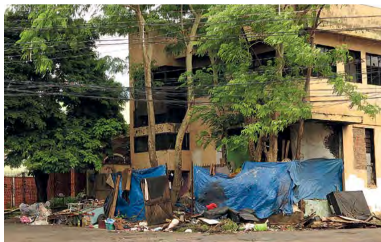
Casa abandonada, invadida, no cruzamento das ruas Visconde de Taunay com Albert Einstein, em frente à Avenida do Café
