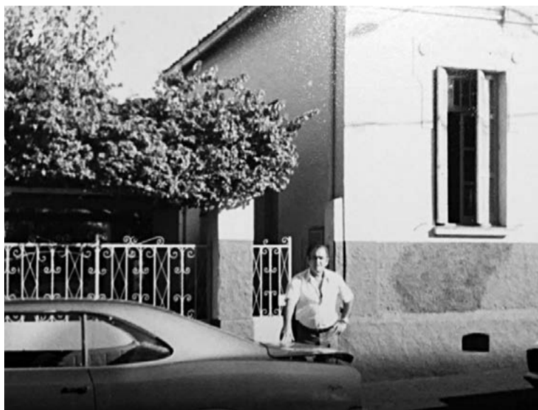
Casa da Rua Castro Alves (não existe mais). foto de Rubens Costa (Anos 70)
