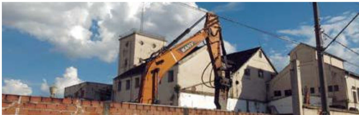
Algumas máquina estão trabalhando com demolição na área da antiga fábrica da Antarctica. O início da construção do Shopping Buriti ainda não está definido, por conta da crise econômica.
