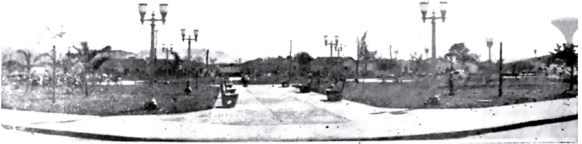
Vista da praça do meio da Dois de Julho, mostrando a caixa d'água no canto. Na época tinha poucas edificações no entorno
