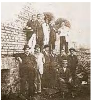
1910 - Fundação da Sociedade Amiga dos Pobres (na foto, início da construção do prédio).
