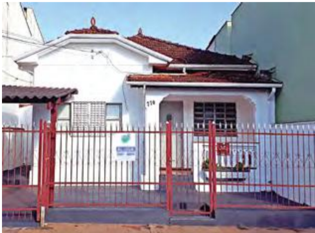
Rua Barão de Cotegipe
